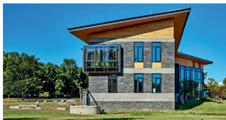
屋顶的雨水被收集起来,储存在建筑物旁边的两个5000加仑的蓄水池中,然后过滤后用作饮用水
