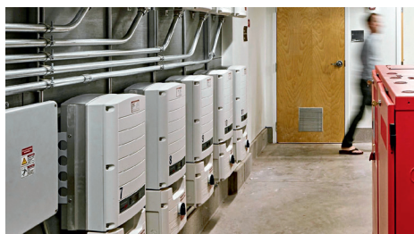
逆变器将太阳能电池板的直流电压转换成家庭和办公室中可用的交流电
