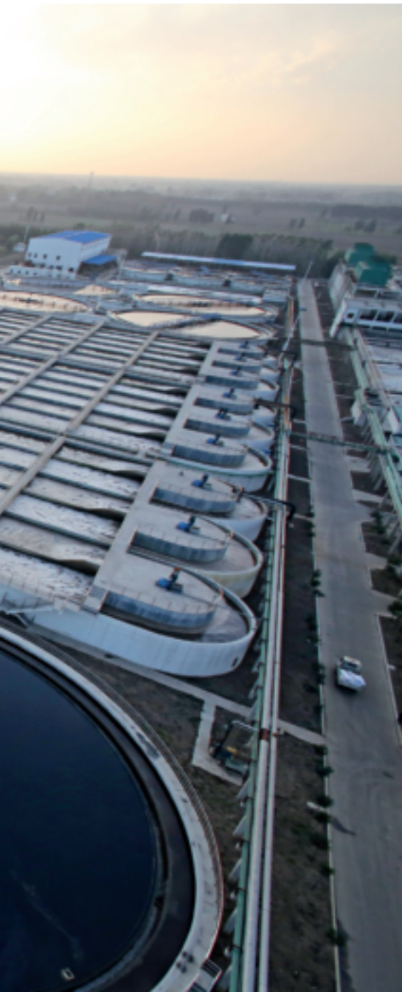
采用氧化沟工艺和磁化催化絮凝沉淀工艺的生产废水处理设施
