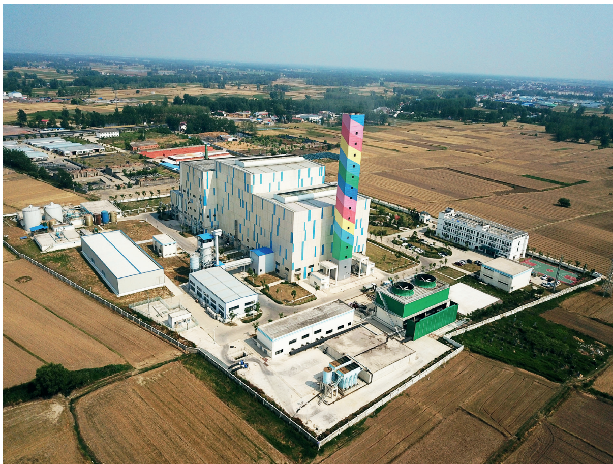
我国中部某生活垃圾焚烧厂 供图 / 芜湖生态协会
