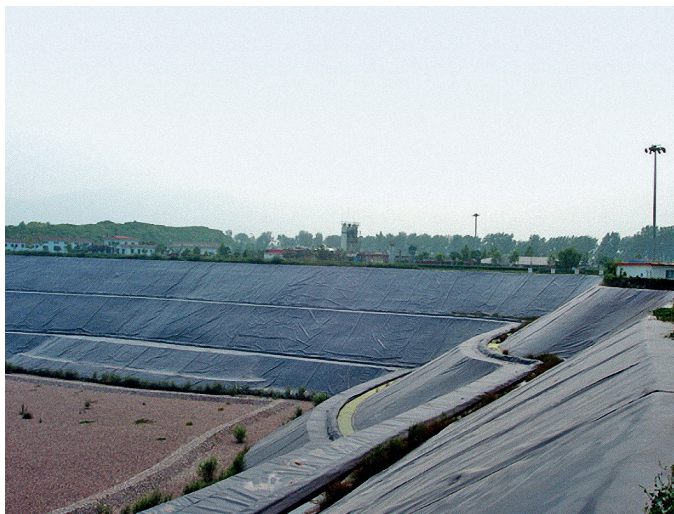
六里屯填埋场复合防渗层 袁光钰/摄
