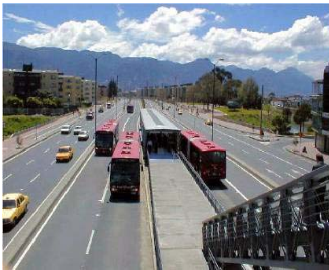
位于中央隔离带的公交专用道（隔离措施）
