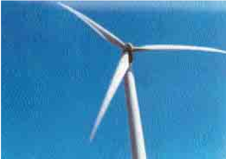
Middelkerke wind turbine.
