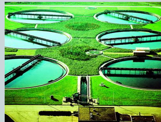
Water Treatment 水处理
